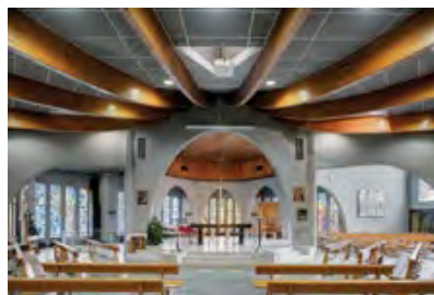
Les grandes poutres en lamellé-collé convergent vers le chœur soulignant le plan en éventail.
